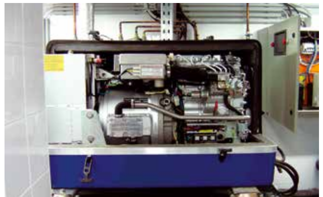
Dieser dreiphasige Panda-Generator ist im Untergeschoss installiert. Hauptsicherungen, Bedienpanel und Kühlersteuerung sind im Schaltschrank enthalten. Bild: Kratos Kft. Ungarn.
